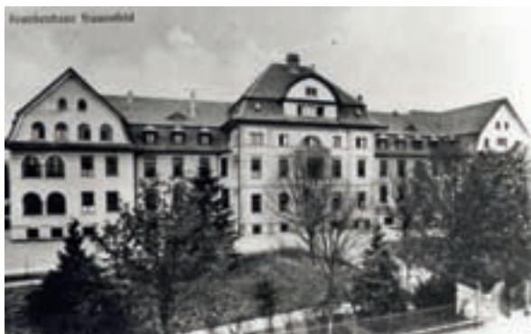
Krankenhaus Frauenfeld 1915, Zürcherstrasse 84
