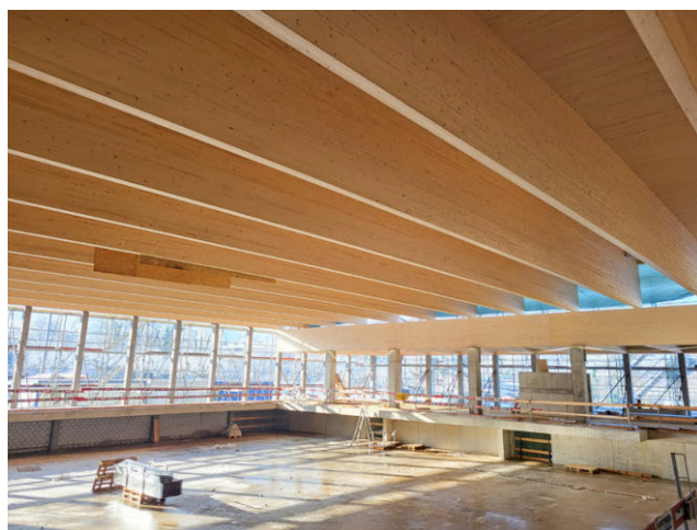
Blick in die Schwimmhalle mit 25 m-Becken
